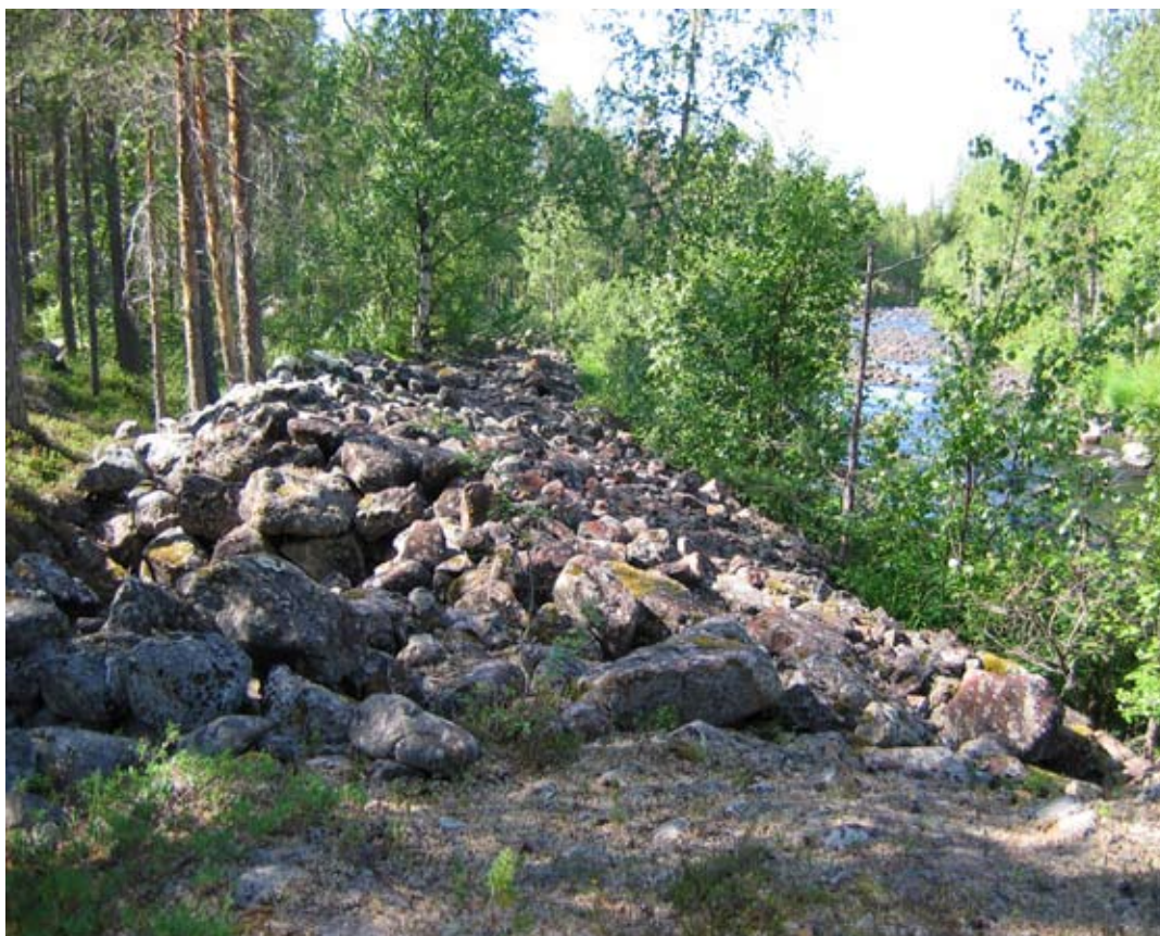
På 1950-talet användes schaktmaskiner för att maka undan sten och jämna till bottnarna så att stockarna lättare skulle kunna flottas. Dessa stenmassor har styrts upp från Mattjokkbäckens bottnar.
